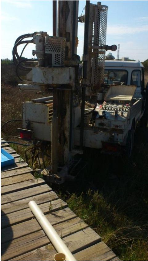
Piezómetro P-1 durante su perforación
