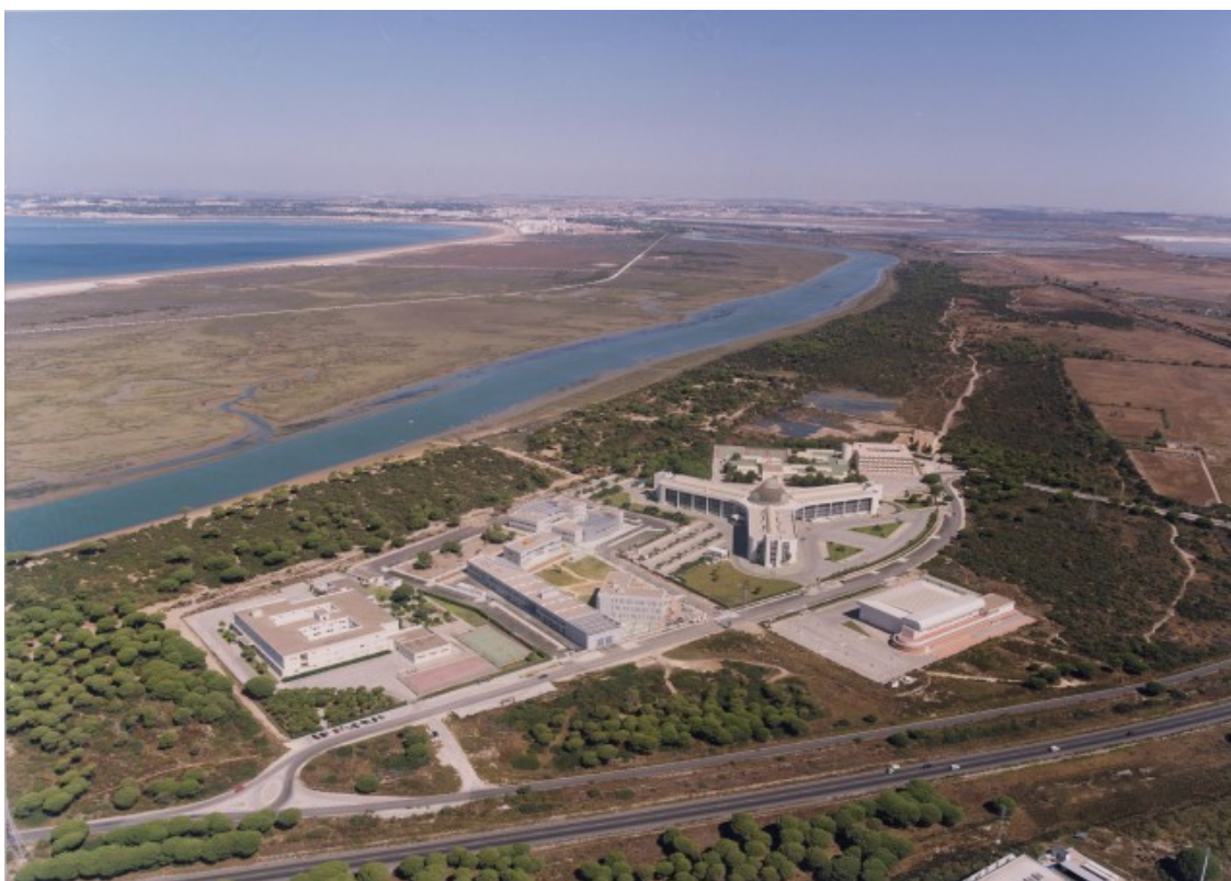
Figura 7.1.- Vista general del Campus del Polígono Río San Pedro en Puerto Real (norte hacia arriba) en la que se observan algunos de los valores ambientales del Parque Natural Bahía de Cádiz: cordones dunares, marismas y zonas endorreicas. (Fuente: UCA).
