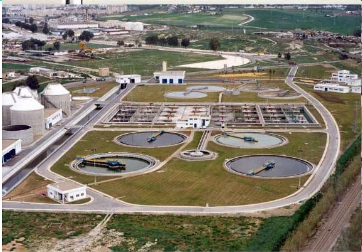
EDAR GUADALETE (JEREZ DE LA FRONTERA)
