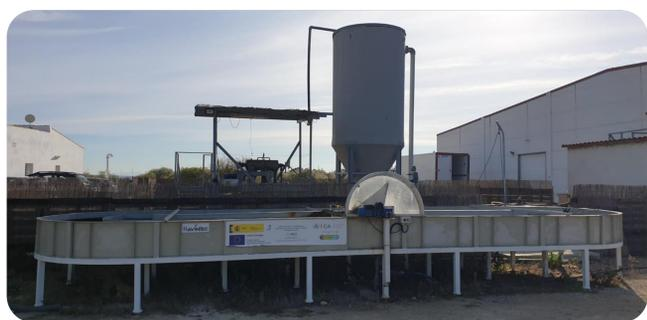
Fig 1. Planta de tratamiento de agua mediante biotecnología de microalgas instalado en CUPIMAR. Configuración en raceway, carrusel o HRAP (High Rate Algae Pond). Volumen= 6.000 litros. Alimentación: efluente procedente del rechazo del rotamiz de tratamiento de aguas del sistema RAS de cultivo. [N]= 14 mg/L; [P]< 1 mg/L.
